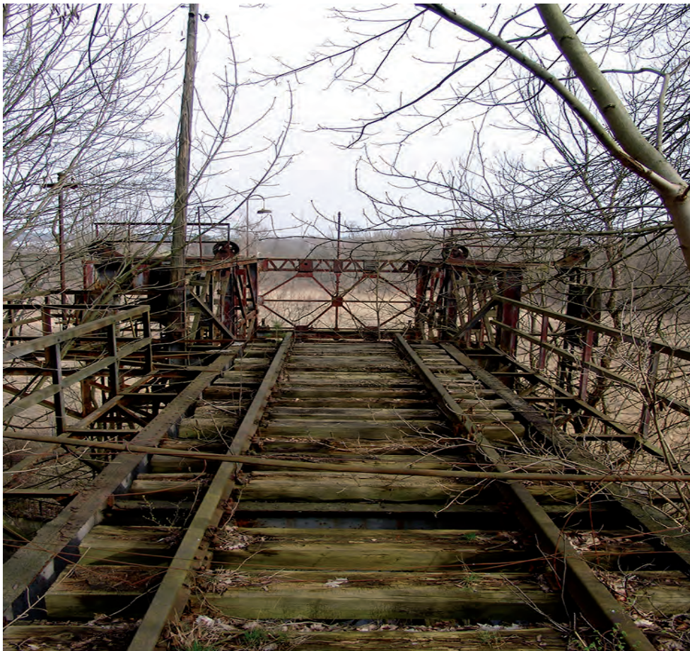
32 Waggonfahrröhre in Eberswalde Foto: Matthias Baxmann, BLDAM, 2007
