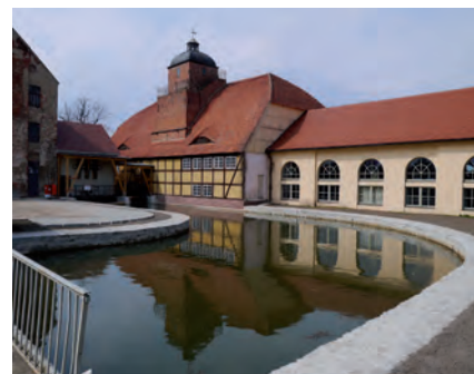
2 Eisenhütten- und Hammerwerk in Peitz Foto: Dietmar Krauß, BLDAM
