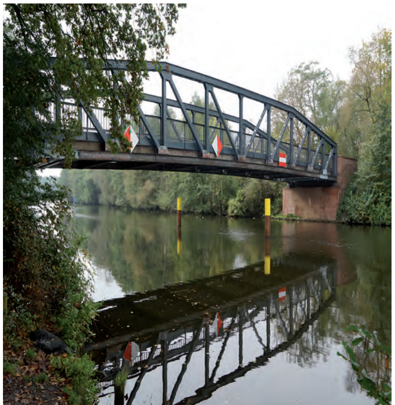
09 Stahlfachwerkbrücke in Bindow Foto: Matthias Baxmann, BLDAM, 2014
