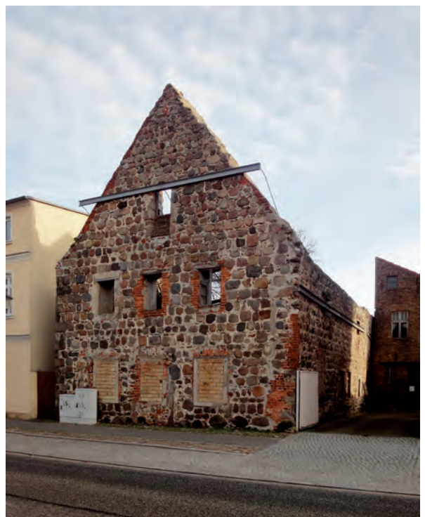
18 Westgiebel des „Klosters“ zur Großstraße mit jetzt vermauertem Zugang aus dem 13. Jahrhundert Foto: Stefanie Wagner, BLDAM
