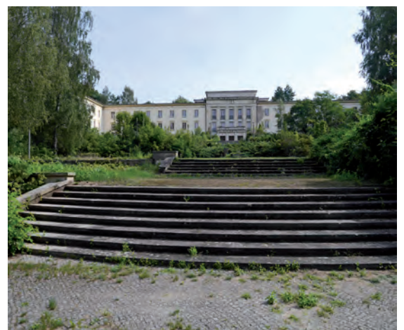
28 Bogensee, Jugendhochschule, Hauptgebäude Foto: Wera Groß, BLDAM
