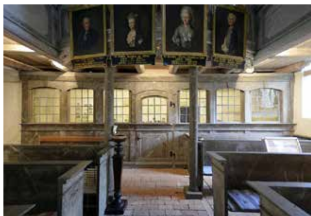
74 Zernikow, Dorfkirche, Blick auf Westempore und Patronatsloge vor der Innenrenovierung, Juli 2016 Foto: S. Bothe, Rheinsberg
