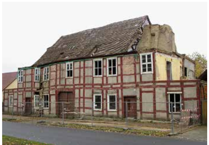
2 Greiffenberg, Breite Straße 17-18, Abriss Foto: J. Wiese
