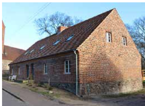
23 Prädikow, Dorfstr.13, nach der Sanierung, 2016 Foto: W. Groß, BLDAM
