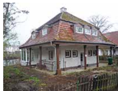
33 Wandlitz, Ansicht von der Straße vor der Sanierung 2014 Foto: S. Gramlich, BLDAM
