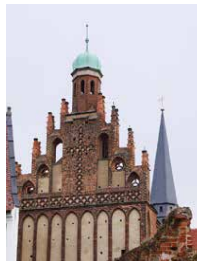
17 Mühlberg, nach dem Wiederaufbau, 2016 Foto: D. Krauß, BLDAM
