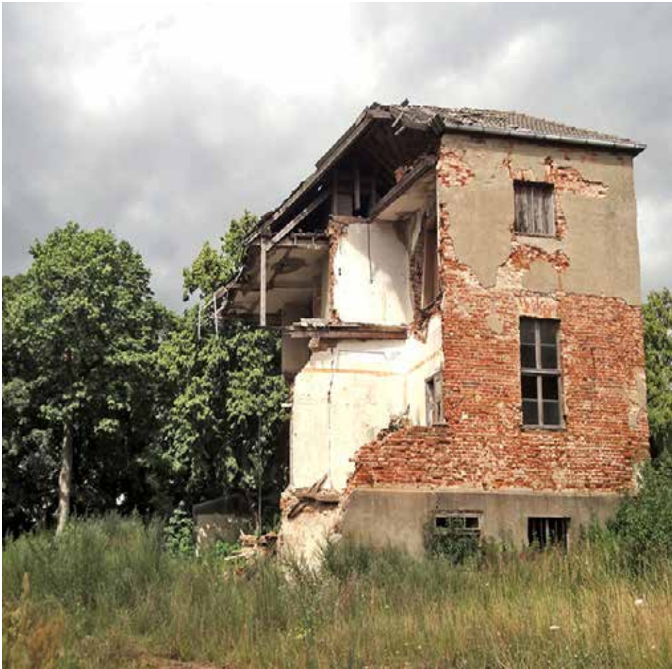
45 Ansicht von Süd, Zustand am 19.7.2016 Foto: S. Wagner (BLDAM)
