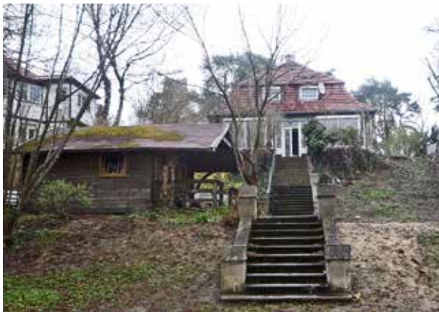
35 Wandlitz, Ansicht von der Seeseite vor der Sanierung 2014 Foto: S. Gramlich, BLDAM
