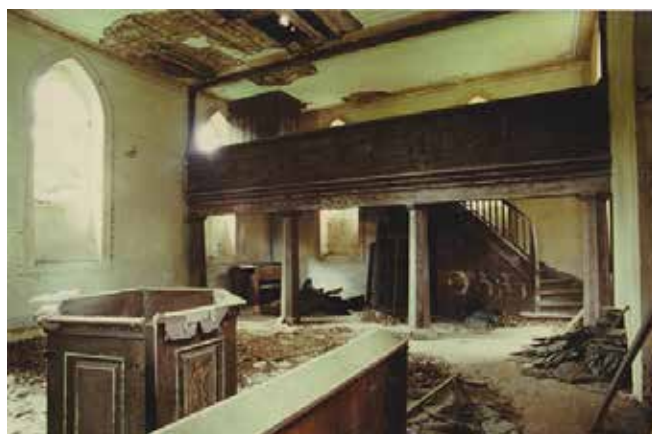
7 Darsikow, Gutskapelle, Innenraum vor der Sanierung, 2010 Foto: Bernd Janowski
