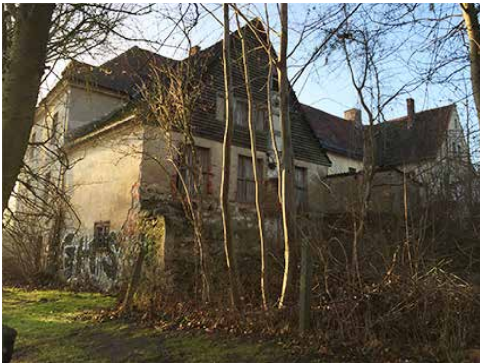
49 Flecken Zechlin, ehem. Amtshaus, Rückseite, 2016 Foto: R. Breetzmann, BLDAM
