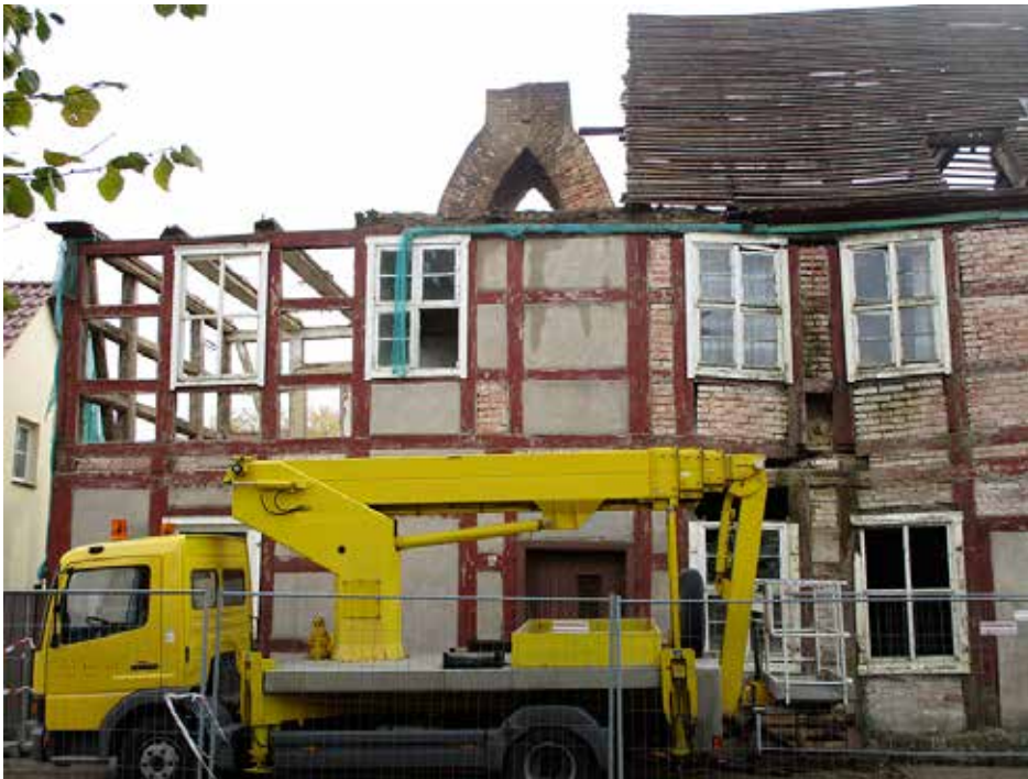
54 Greiffenberg Breite Straße 17-18, Abriss am 21.10.16 Foto: J. Wiese
