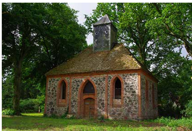
6 Darsikow, Gutskapelle, vor der Sanierung, 2010 Foto: Sibille Podorf
