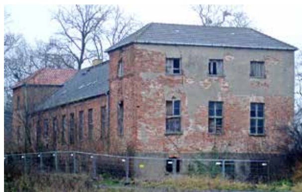
40 Ansicht von Südsüdwest (aus Richtung Hof) Foto: G. Frank, BLDAM
