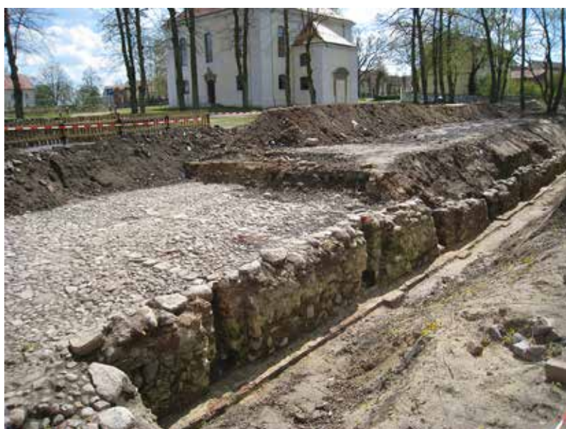
61 Altlandsberg, freigelegte Pflasterfläche der ehemaligen Schlossterrasse und Feldsteinmauer mit davor liegendem Fundamentstreifen der Ziegelsteinmauer als Begrenzung des ehemaligen barocken Lustgartens um 1710, Aufnahme 2016 Foto: H.-J. Dreger, BLDAM
