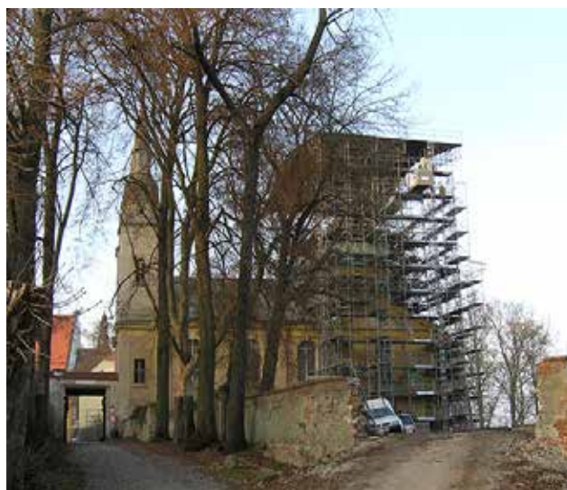
19 Kloster Neuzelle, evangelische Pfarrkirche „Zum heiligen Kreuz“, Zustand während der Baumaßnahmen, 2011 Foto: A.Niemann, BLDAM
