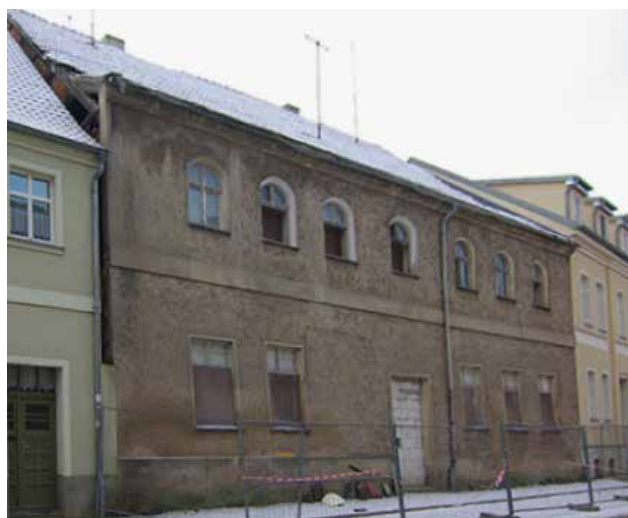
37 Die unscheinbare Straßenfassade lässt kaum erahnen, was für ein bauhistorischer Schatz für Beeskow hier verborgen ist. Foto: H. Türk, BLDAM
