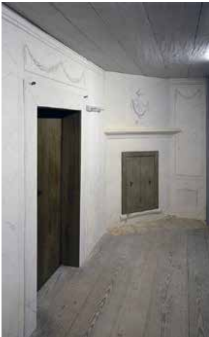
76 Zernikow, Dorfkirche, nach der Restaurierung, Blick nach Norden, Oktober 2016 Foto: S. Bothe, Rheinsberg
