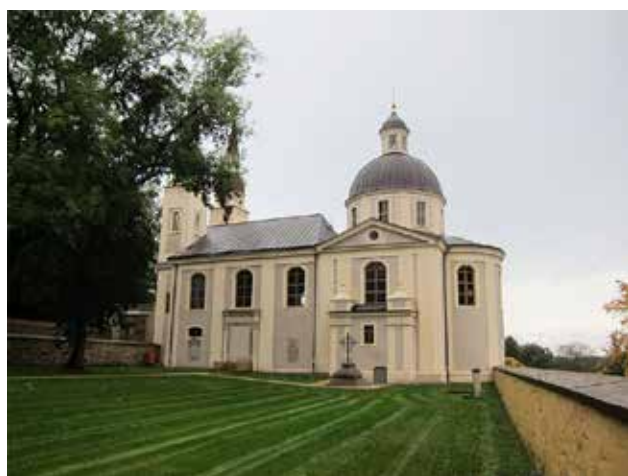
20 Kloster Neuzelle, evangelischen Pfarrkirche „Zum heiligen Kreuz“, Zustand nach der Sanierung, 2016 Foto: A. Niemann, BLDAM
