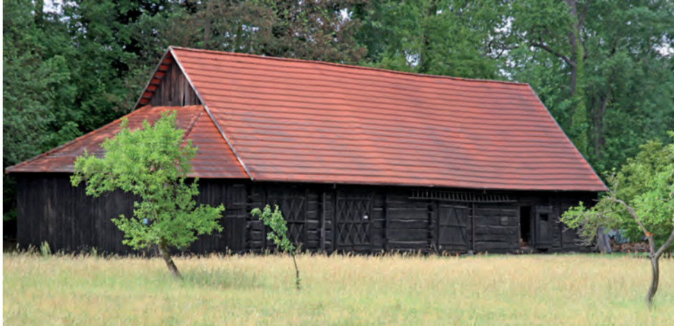
51 Das Wirtschaftsgebäude an der Ringchaussee im Mai 2017 Bild: Dieter Hübener, BLDAM
