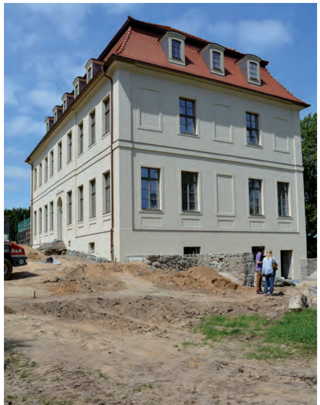
23 Ansicht von Süden während der Fassadensanierung Bild: Hans Burger, BLDAM, 2017
