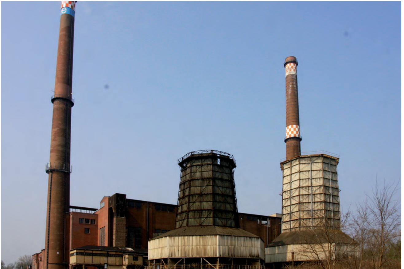
35 Kraftwerk Plessa, Kühlturm Bild: Matthias Baxmann, BLDAM, 2010
