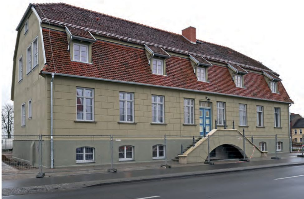
21 Das „Kettenhaus“ in Prenzlau nach der Sanierung im Jahr 2017 Bild: Wera Groß, BLDAM
