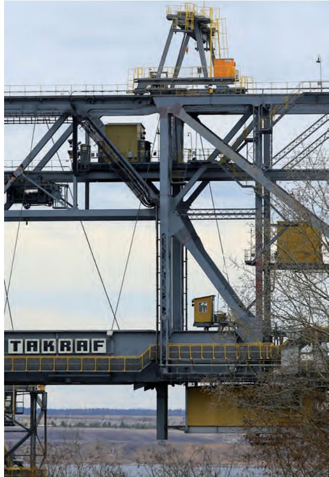
7 Denkmalgerecht und funktionstüchtig saniert: Bockkran F 60 Bild: Matthias Baxmann, 2016
