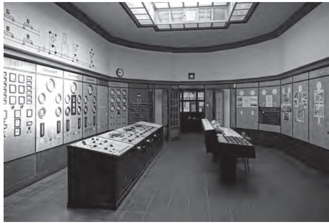
36 Kraftwerk Plessa, Schaltwarte Bild: Matthias Baxmann, BLDAM, 2017
