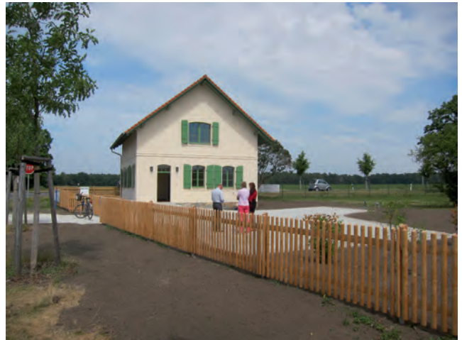
3 Das sanierte Chausseehaus Bild: Alexander Niemann, BLDAM, 2017
