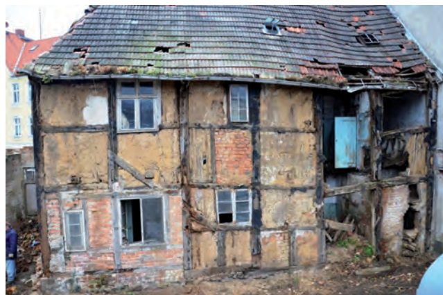
32 Hofseite vor der Sanierung Bild: Haiko Türk, BLDAM, 2017
