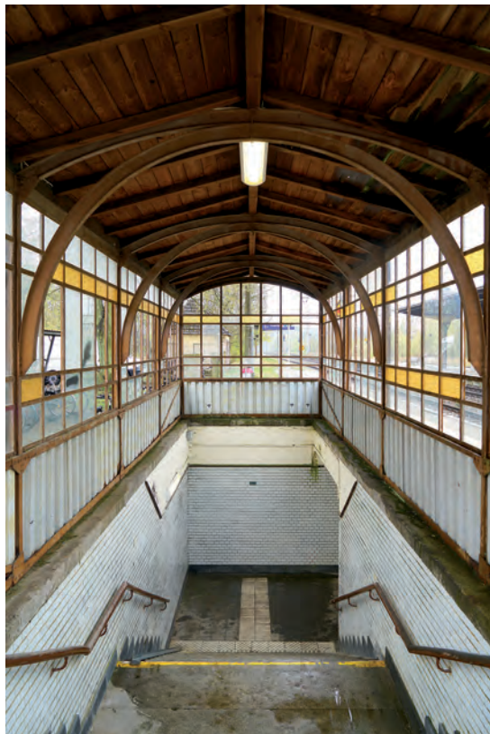
63 Tunneltreppe Hausbahnsteig, 2017 Bild: Matthias Baxmann, BLDAM
