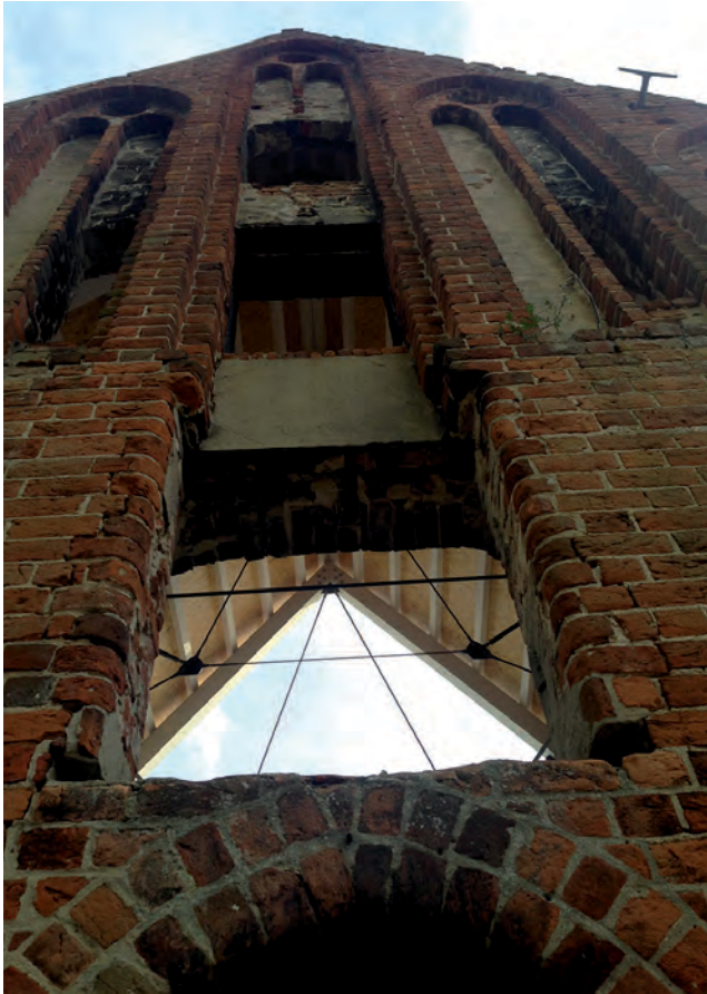
25 Die Giebelwand mit der dahinterliegenden neuen Dachkonstruktion Bild: Sarah Wiesner, BLDAM
