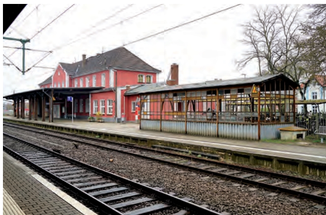
64 Hausbahnsteig mit Bahnsteigdach, Bahnhofsgebäude und Treppenvavillon, 2017 Bild: Matthias Baxmann, BLDAM
