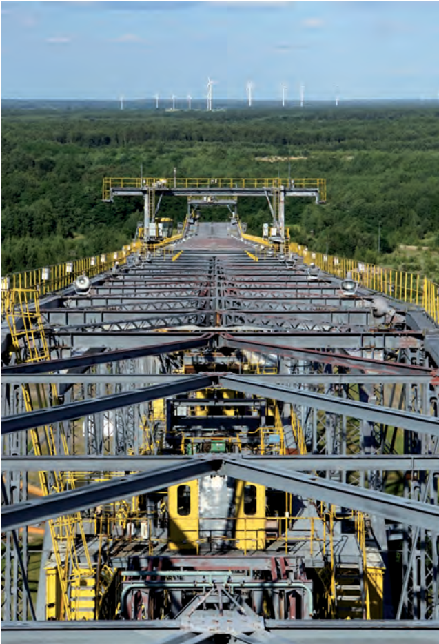
6 In 80 m Höhe, Bock-/Portalkran auf den oberen Längsträgern der Brücke Bild: Matthias Baxmann, 2014
