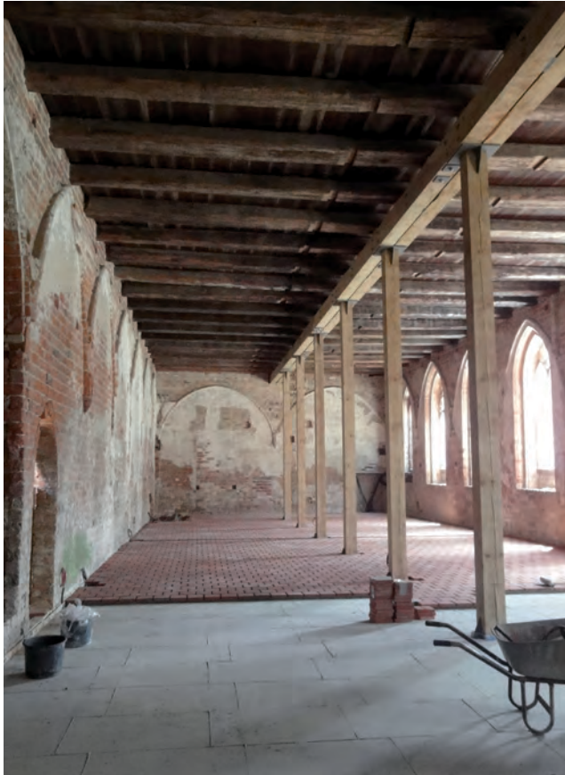
14 Blick in das Laienrefektorium während der Sanierung Bild: Stefanie Wagner, BLDAM
