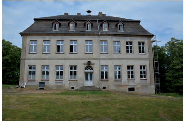
22 Ansicht von Südwesten vor der Fassadensanierung Bild: Hans Burger, BLDAM, 2016
