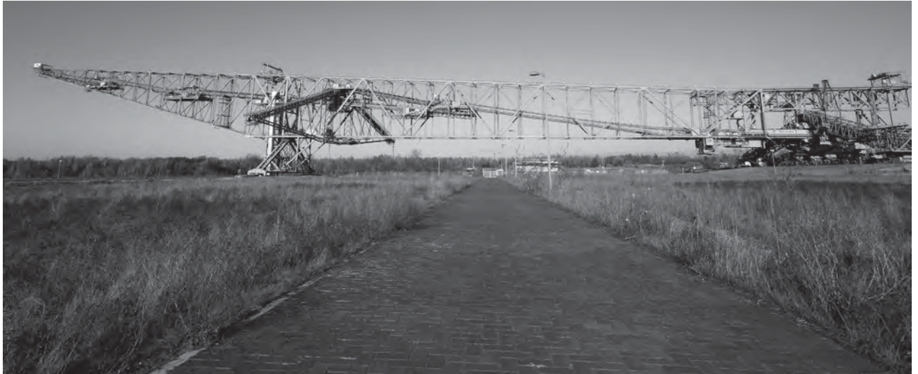
5 Stillgelegt am ursprünglichen Montageort: Abraumförderbrücke, Typ F60 des ehemaligen Braunkohletagebaus Klettwitz-Nord, Blick aus Richtung Bergheider See, Bild: Matthias Baxmann, BLDAM, 2009
