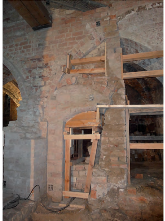
15 Cellarium, Blick zur Süd-Ost-Ecke des großen Kellerraums mit Spuren einer gemauerten Treppe zum Erdgeschoss über der Durchgangsöffnung Bild: Stefanie Wagner, BLDAM
