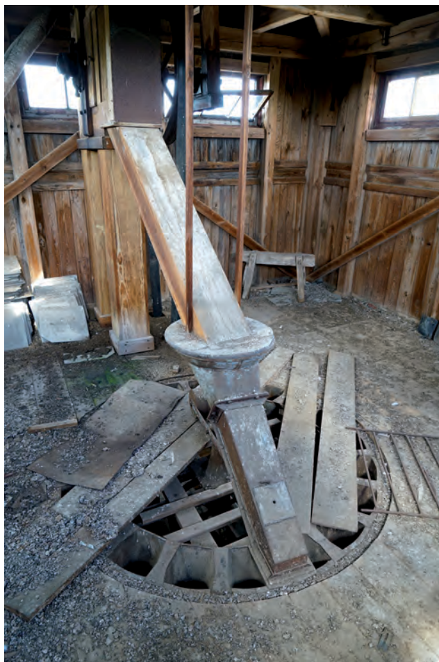
61 Rohrverteilungsanlage zur Befüllung der Zellspeicher Bild: Matthias Baxmann, BLDAM
