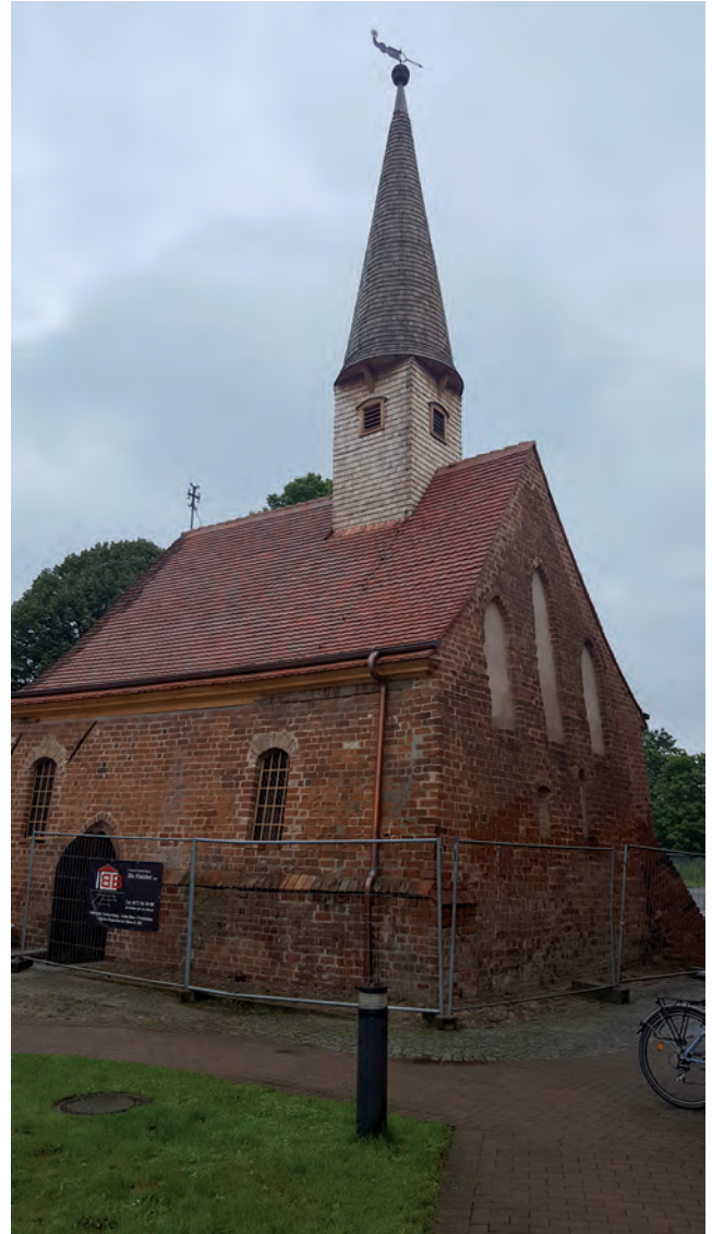
30 Nordseite der Kapelle Bild: Haiko Türk, BLDAM, 2017
