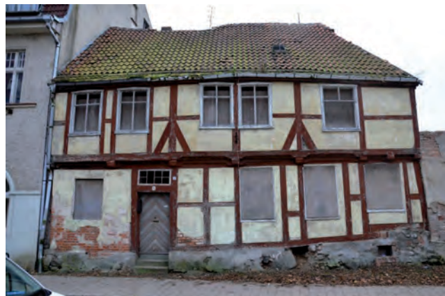
31 Straßenseite vor der Sanierung Bild: Haiko Türk, BLDAM, 2017
