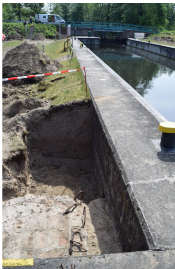
2 Ausgrabung an der Schleuse in Ruhlsdorf. Foto: D. Schulz, BLDAM
