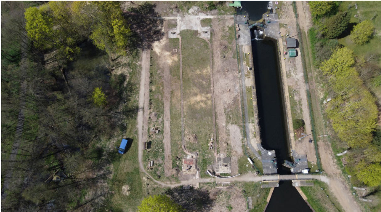
31 Drohnenaufnahme Doppelschleusenstandort Leeserbrück mit der (heute verfüllten) I. Schleuse von 1852 (links) und der noch in Betrieb befindlichen II. Schleuse von 1878 (rechts), Blick v. O. Foto: Wasserstraßen- und Schifffahrtsamt Oder-Havel/Zweckverband Region Finowkanal
