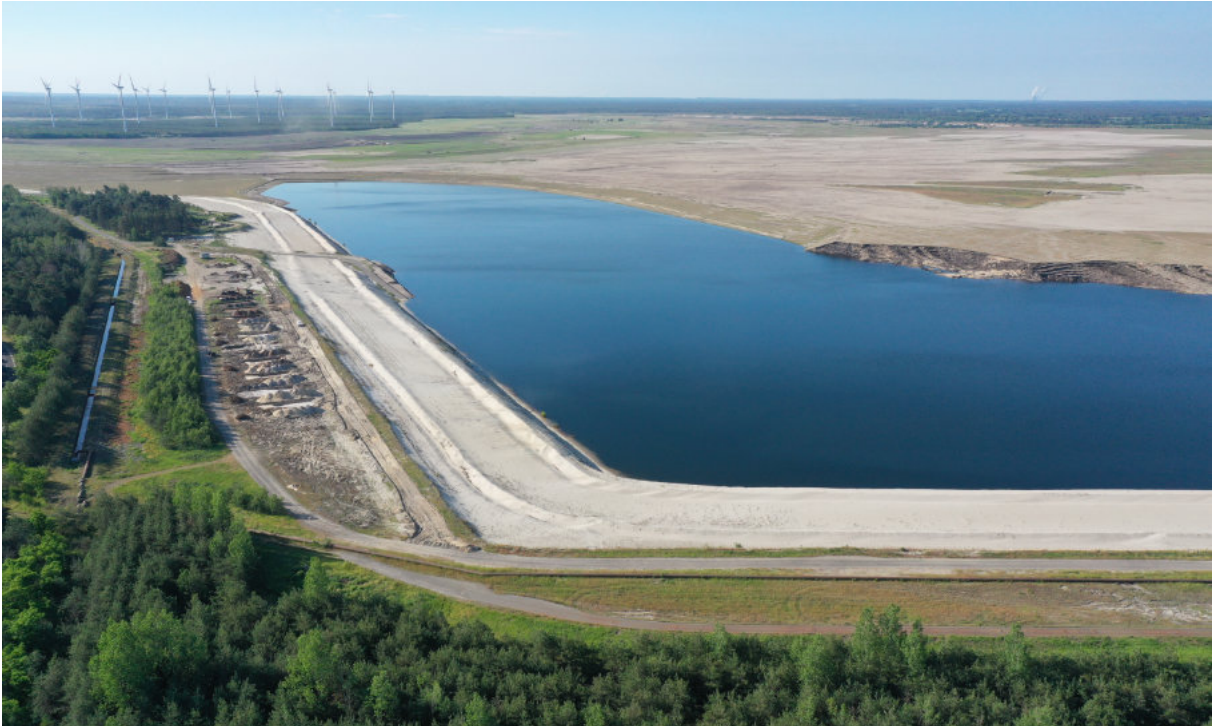
19 Uferabflachung am nordöstlichen Rand des ehemaligen Tagebaus Cottbus-Nord (Cottbuser Ostsee), Blick nach Südosten. Foto: M. Schneider, BLDAM
