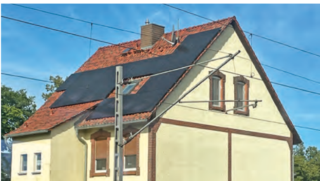
Negativbeispiel: verspringende, unruhige Anordnung. Das eigentliche Dach stellt nur noch eine Restfläche dar
