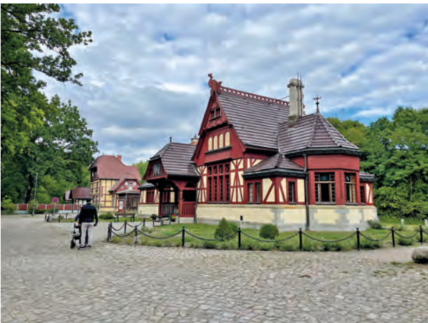
Bei sehr exponiert stehenden Denkmälern sind alle Dachflächen einsehbar und gehören oft wesentlich zum hohen gestalterischen Anspruch; Kaiserbahnhof Joachimsthal (BAR)
