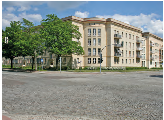
Flachgeneigte Dächer der Gebäude des 20. Jahrhunderts sind oft nicht einsehbar, Eisenhüttenstadt (LOS)
