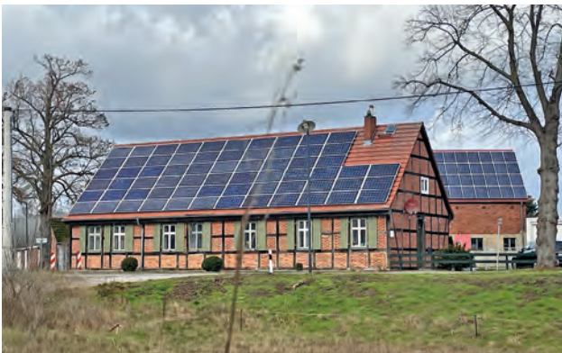
Negativbeispiel: Die Anlagen überdecken fast vollflächig die Dächer. Sie sind weit sichtbar und stehen im starken Kontrast zu Material und Farbe der traditionellen Bauten
