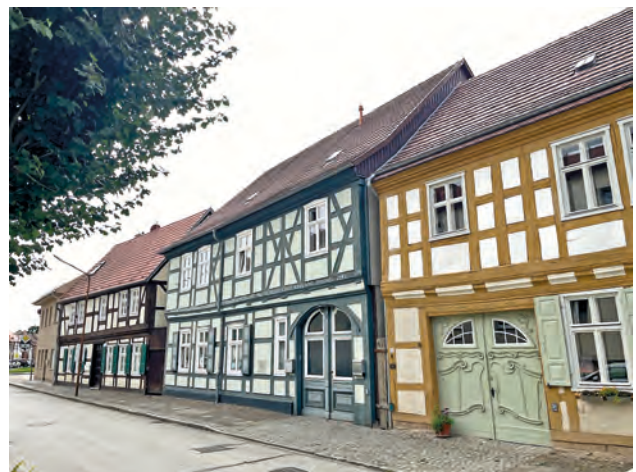
Material- und werkgerecht wiederhergestellte Dächer sind wesentlich für die Wirkung von historischen Bauten; Wusterhausen/Dosse (OPR)
