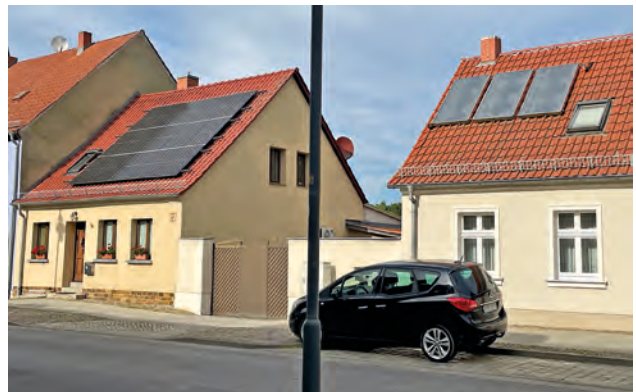
Negativbeispiel: Im öffentlichen Stadtraum können sich unterschiedliche Anlagentypen sehr exponiert sammeln. Das qualitätvolle Stadtbild wird dabei erheblich beeinträchtigt
