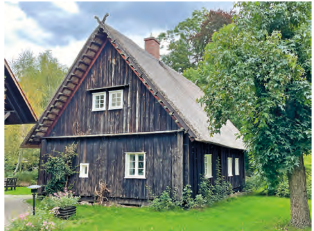
Reetdächer waren Ortstypisch für den Spreewald. Sie sind aber selten geworden und sind besonders schützenswert; Spreewalddorf Lehde (OSL)
