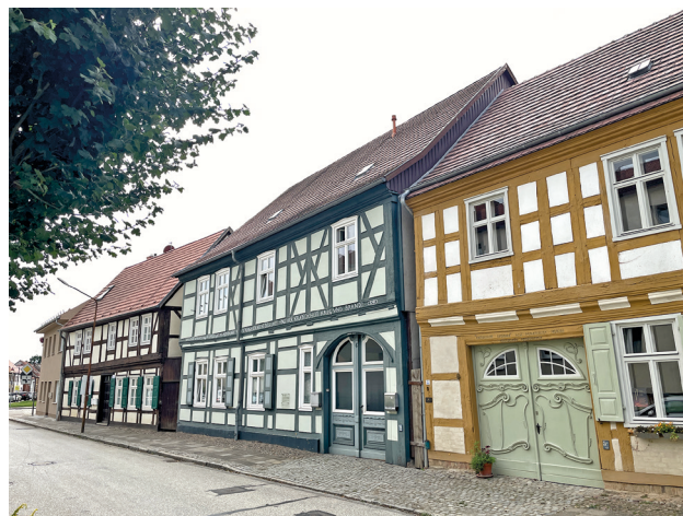
Material- und werkgerecht wiederhergestellte Dächer sind wesentlich für die Wirkung von historischen Bauten; Wusterhausen/Dosse (OPR)
