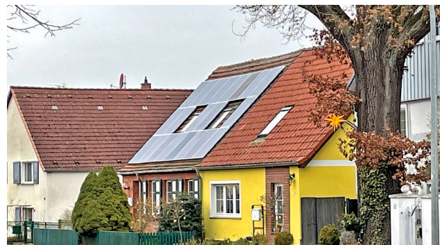
Negativbeispiel: Auch dunkle Module können sich durch Spiegelung stark von der Dachfläche abheben
