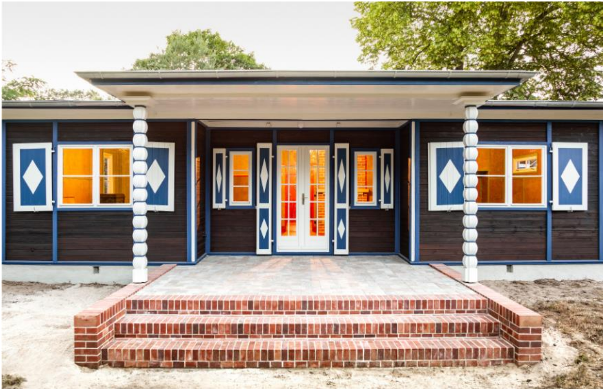
Der Eingang des Alexander-Hauses. Foto: André Wagner, Alexanderhaus.
