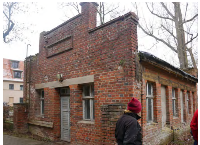
40 Team der Berliner Hochschule für Technik am Teehaus im Gutspark von Radensleben zur Vorbereitung der photogrammetrischen Bauaufnahme. Foto: Andrea Sonnleitner, BLDAM, 2023
