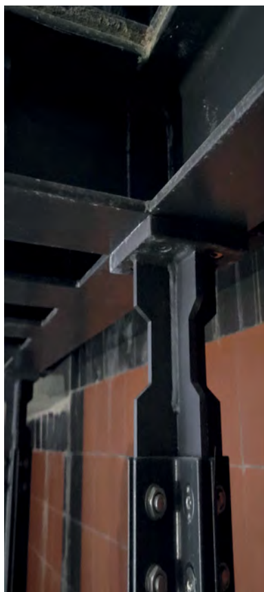
43 Stahnsdorf, Mausoleum Harteneck, Detailaufnahme der neuen Tragkonstruktion in der Gruft. Foto: Sven Jeschke, BLDAM, 2023
