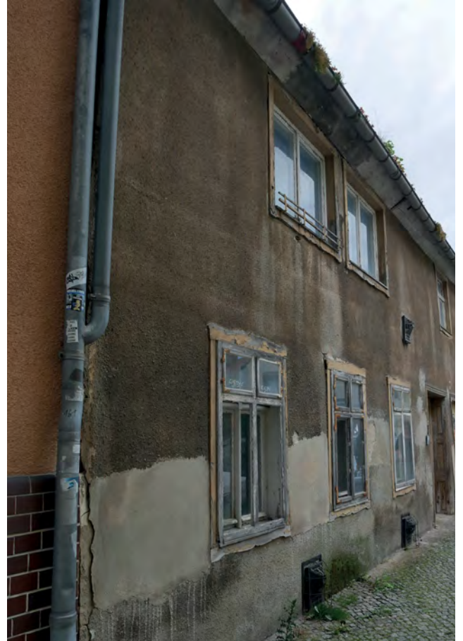
20 Straßenansicht Moritzstraße 9 in Finsterwalde. Foto: Andrea Sonnleitner, BLDAM, 2023
