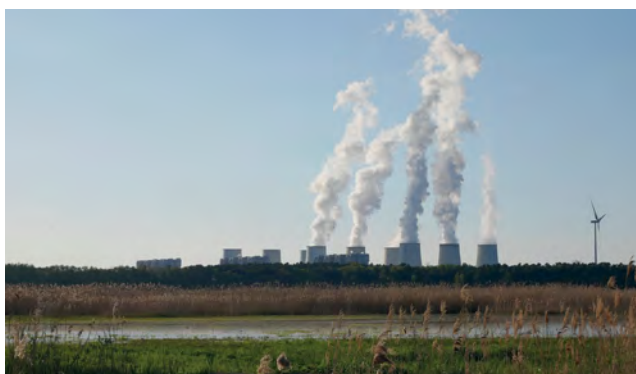
46 Kraftwerk Jänschwalde. Foto: Kaja Boelcke, BLDAM, 2023
