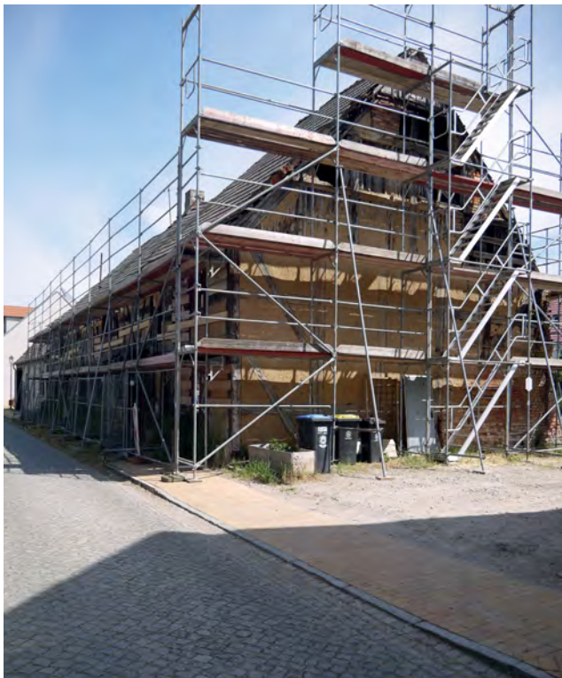
12 Liebenwalde, während der Sicherung. Foto: Marie Mamerow, BLDAM, 2023
