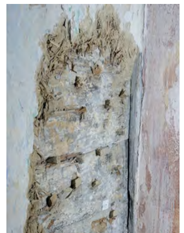
22 Finsterwalde, die Blockwand der Stube ist an den Raumecken in Ständer eingnutet Foto: Andrea Sonnleitner, BLDAM, 2023
