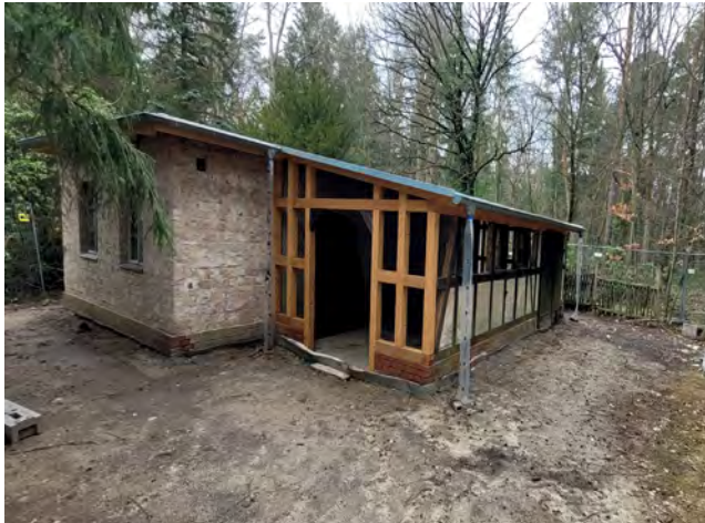
42 Stahnsdorf, Trägerhaus, aktueller Bauzustand. Foto: Sven Jeschke, BLDAM, 2023
