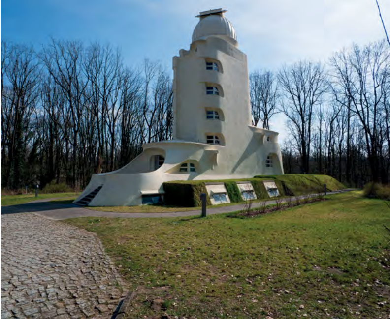
17 Potsdam, Ansicht des Turms von Norden nach der Sanierung. Foto: Haiko Türk, BLDAM, 2024
