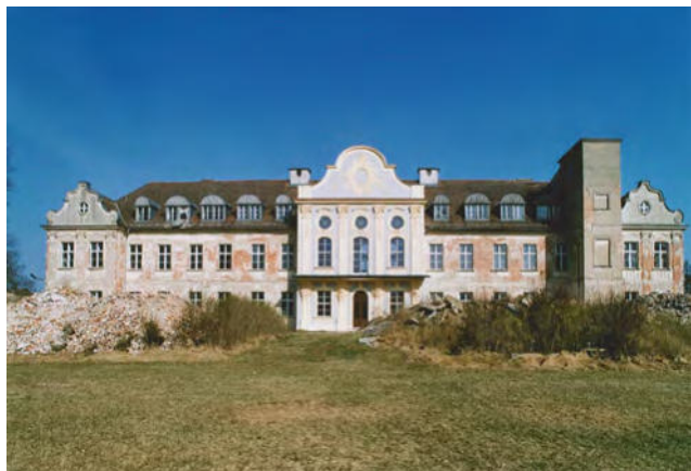
1: Gartenseite des Schlosses in Fürstenberg/Havel vor der Sanierung. Foto: Matthias Metzler, BLDAM, 2012
