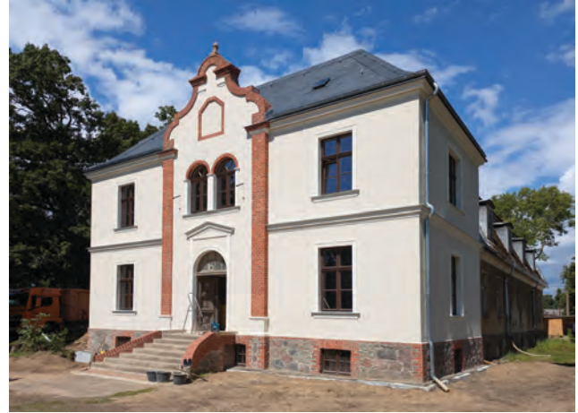
Altfriedland, Kopfbau des Gutshauses, 2025. Foto: Wera Groß, BLDAM
