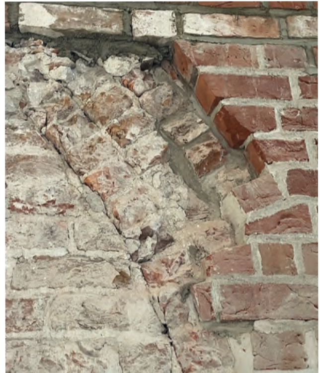
Erdgeschoss, Westwand, Mauerwerkssanierung unter größtmöglicher Beibehaltung der Befunde, 2025. Foto: A. Salgo, BLDAM
