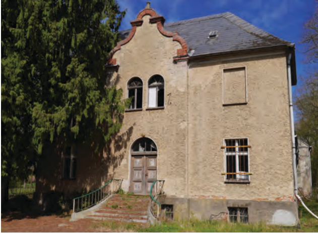
Altfriedland, Kopfbau des Gutshauses, 2019. Foto: Wera Groß, BLDAM
