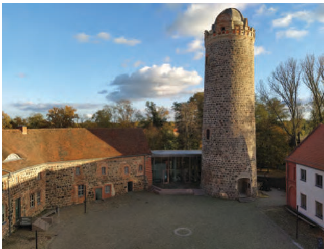
Blick auf den Ostflügel der Bischofsburg. Der Südteil des "Alten Richterhauses" wurde zum Bergfried hin durch einen Neubau ergänzt, 2020. Foto: Ellen Egel, BLDAM
