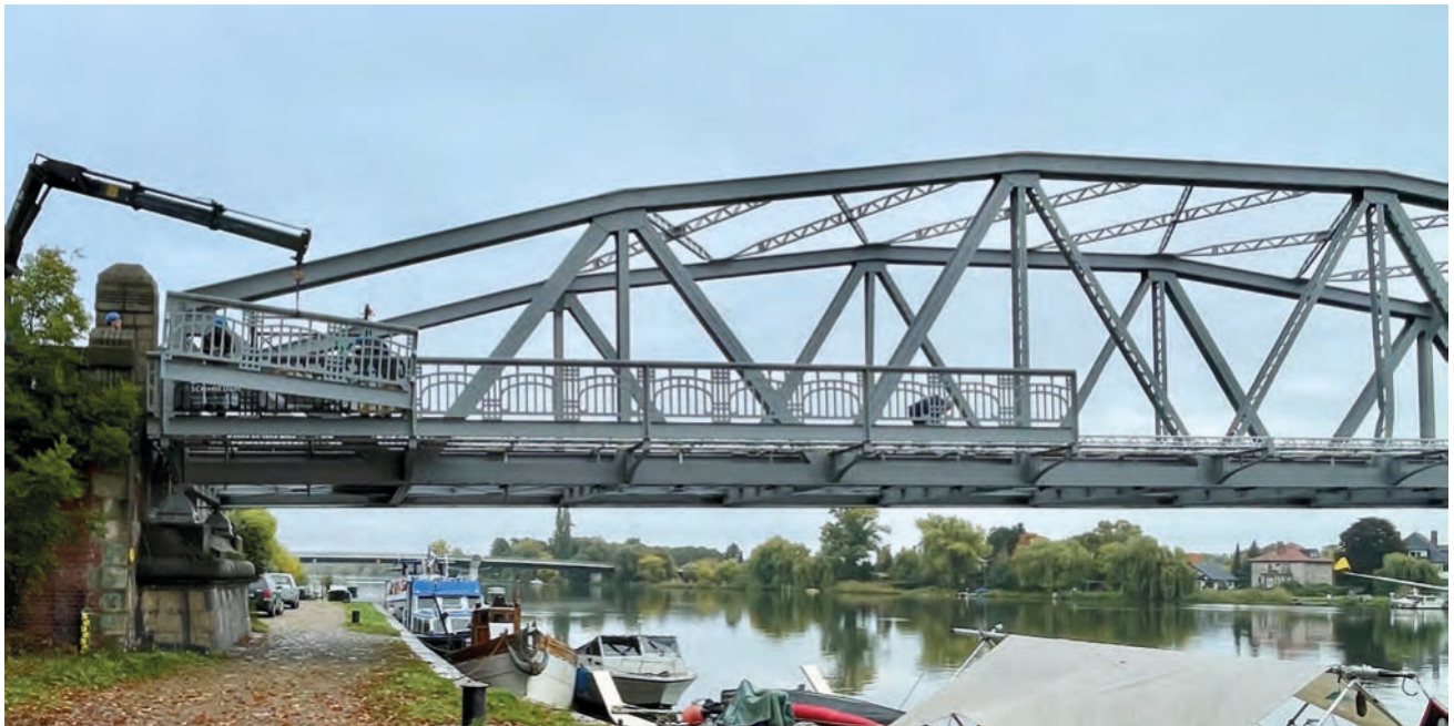
Plauer Brücke mit Remontierung der ersten restaurierten Geländersegmente am 8.10.2025. Foto: V. Taubert, BLDAM
