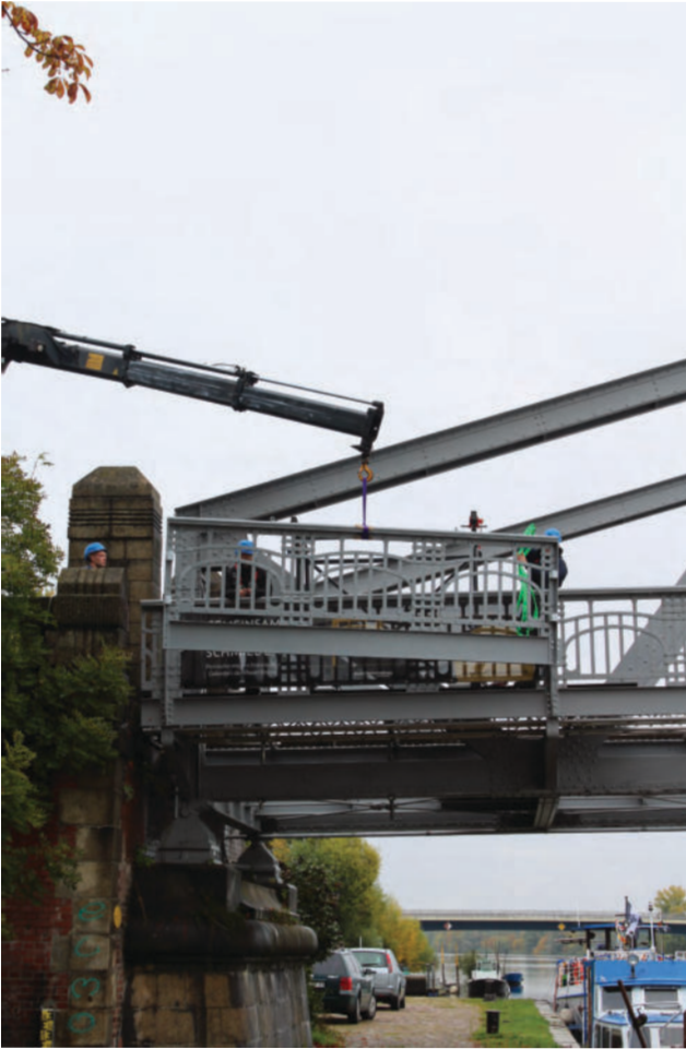
2 Brandenburg an der Havel, Plauer Brücke, 2025. Foto: Stefanie Veeck, BLDAM
