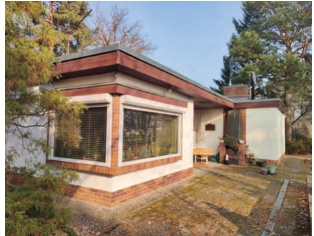
Gartenseite des Hauses Könitzer in Glienicke/Nordbahn. Foto: Matthias Metzler, BLDAM
