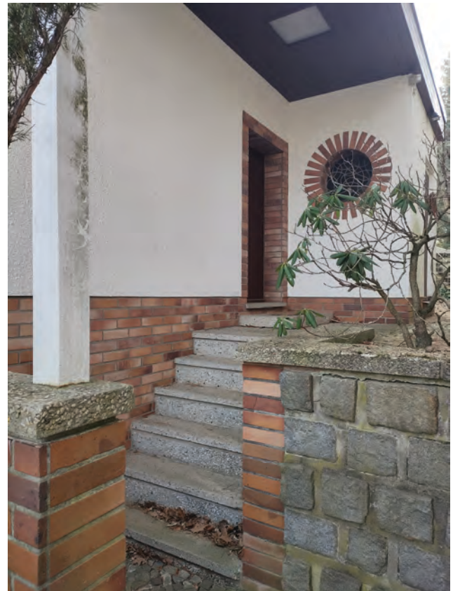
Straßenseitiger Eingang des Hauses Könitzer in Glienicke/Nordbahn. Foto: Matthias Metzler, BLDAM
