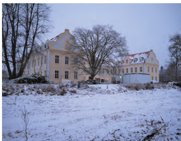
3: Südostansicht im Zuge der Sanierung. Foto: Marie Mamerow, BLDAM, 2026
