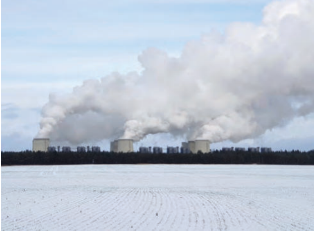
Kraftwerk Jänschwalde von Süden. Foto: Louise Warnow, BLDAM, 2024
