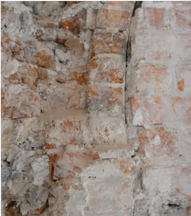
Erdgeschoss, abgeschlagener Gewölbeansatz, vermauerte Wandnische mit Farbschichten, Kapitell aus Ziegelformsteinen, 2025. Foto: A. Sonnleitner, BLDAM
