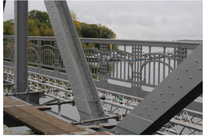
2 Brandenburg an der Havel, Plauer Brücke, 2025. Foto: Stefanie Veeck, BLDAM
