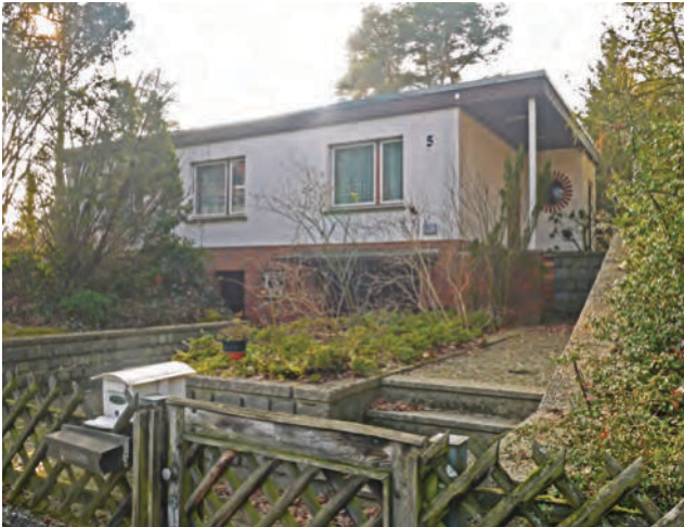
Straßenseite des Hauses Könitzer in Glienicke/Nordbahn. Foto: Matthias Metzler, BLDAM
