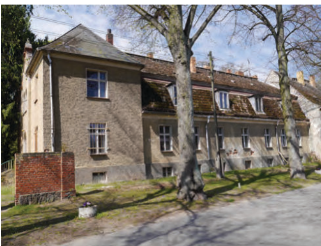
Altfriedland, Straßenansicht des Gutshauses, 2019. Foto: Wera Groß, BLDAM
