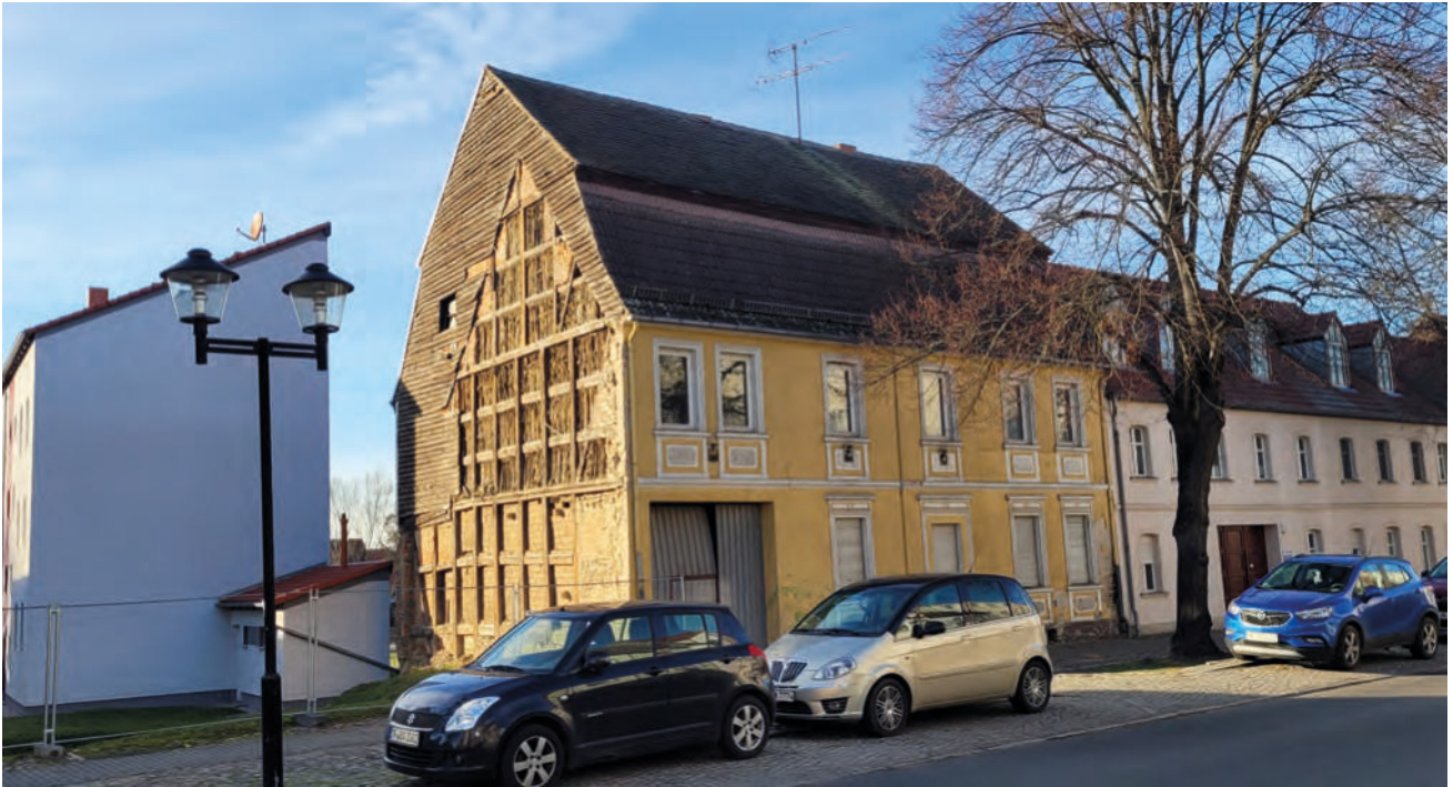
Straßenansicht des Wohnhauses. Foto: Sven Jeschke, BLDAM, 2023
